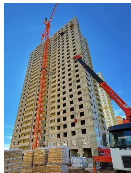
ТДК-8.180 на строительстве ЖК «Акварель», г. Уфа
