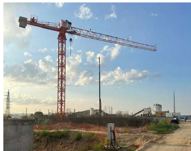
Монтаж 4-х башенных кранов TDK-10.180, г. Благовещенск
