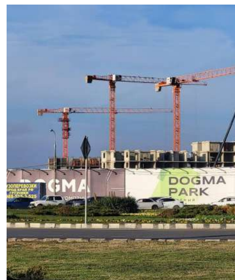
Четыре крана TDK-8.180 на строительстве жилых кварталов, г. Краснодар
