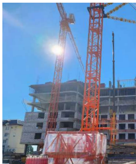
Два крана TDK-10.180 на строительстве жилого дома, г. Ставрополь
