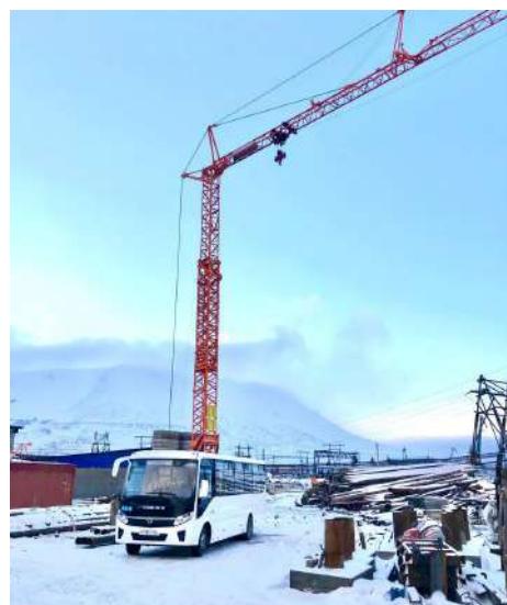
Кран SMK-5.66 на горно-металлургическом комбинате, г. Норильск
