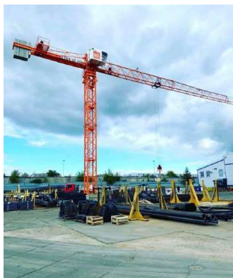
Два крана TDK-10.180 на заводе промышленного цинкования, г. Тула
