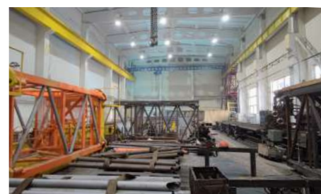
Ремонт, благоустройство и организация рабочих мест
