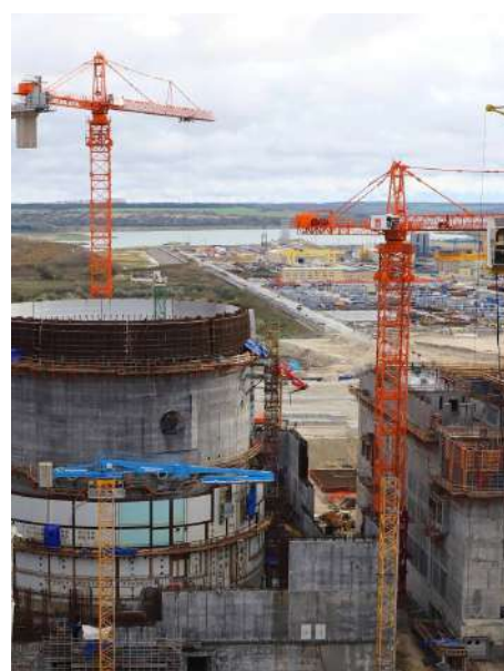
Краны GIRAFFE на строительстве реакторного здания Курской АЭС-2
