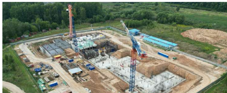
Два башенных крана TDK-10.215 задействованы в строительстве межрайонного медицинского центра площадью 17,5 тыс. кв.м в Тверской области
