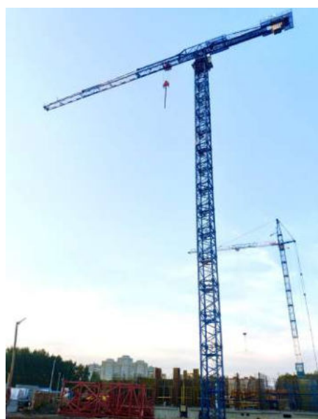
TDK-10.215 на строительстве ЖК «Зеленая река», г. Омск
