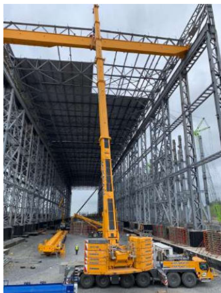
Монтаж МК 135 и 125 т на строящемся заводе, Хабаровский край
