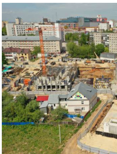
TDK-8.180 и TDK-10.180 на строительстве ЖК «ТЕТРА», г. Нижний Новгород
