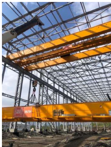
Монтаж двух МК 35 т на строящемся заводе, г. Верхний Уфалей
